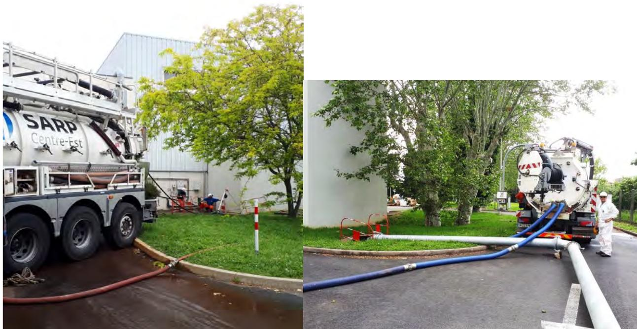
*Opération de curage du collecteur entrée station avec mise en place d'un pompage provisoire pour maintenir l'alimentation de la station en eaux usées*
