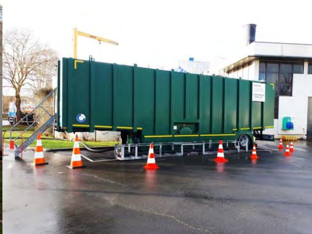
*Opération de vidange et nettoyage de l'épaisseur avec mise en place d'un stockage des boues provisoire permettant de maintenir le fonctionnement de l'atelier déshydratation*
