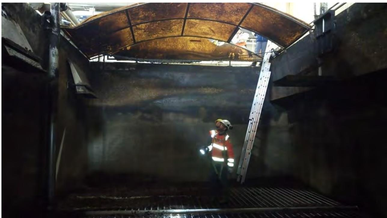
*Opération de vidange et inspection d'un filtre biocarbone*
