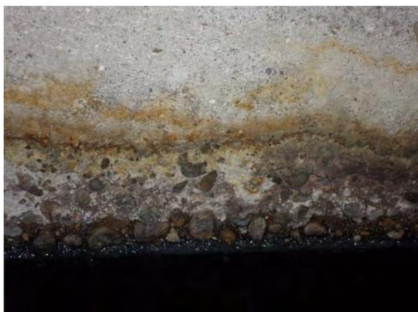
Attaque des bétons au-dessus du niveau liquide sur les Densadeg
