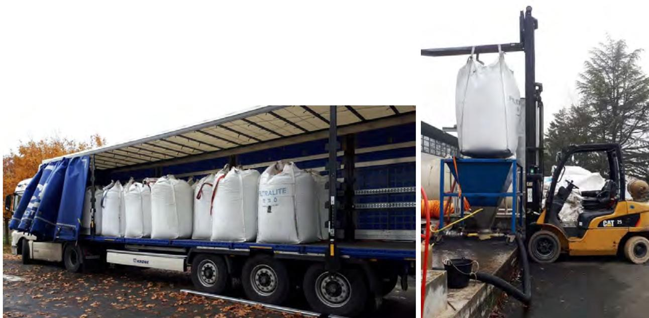
*Opération de rechargement en biolite neuve des filtres biofor C+N*
